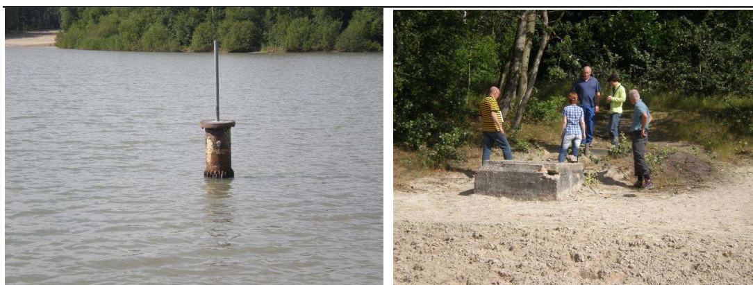
Figuur 3.7 Inlaat pomp (l) en pompkelder (r) aan noordwestzijde zwemplas 't Zand.
